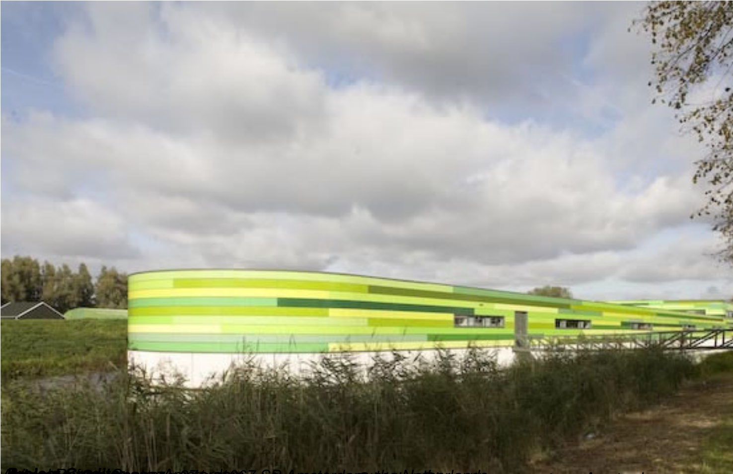
Project: Animal Refuge Centre Amsterdam, Berg, van Arons en Gelauff Architecten, Amsterdam, 2008
